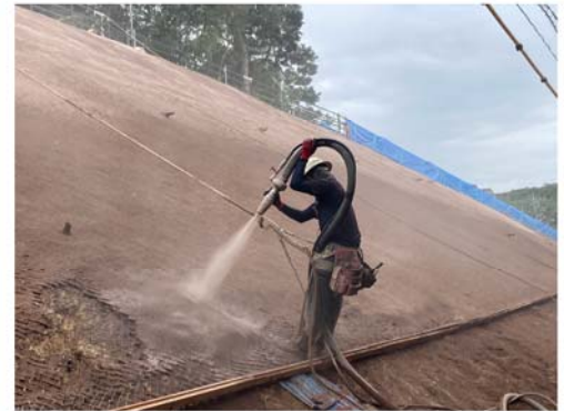
切土法面吹付
