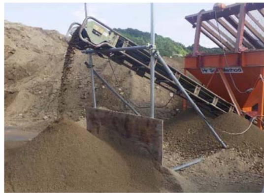
吹付用土砂 粒径処理完了
