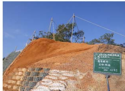
着色吹付完了(バイフェロックス4960)
