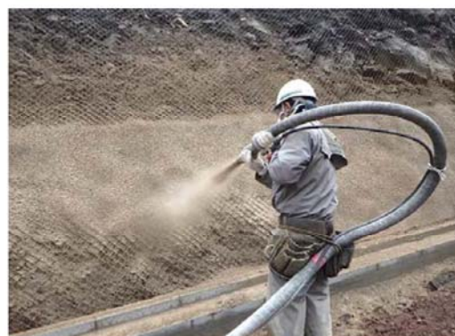
乾式吹付作業
