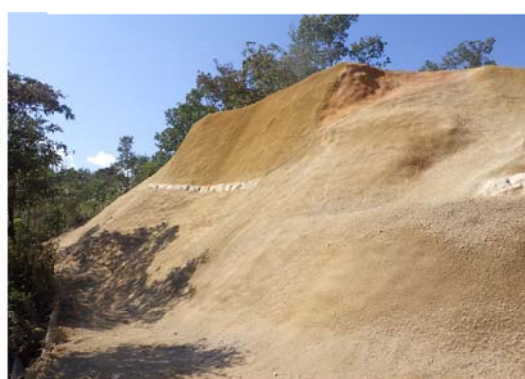
史跡整備工事 土系吹付による成形仕上【本設タイプ】
