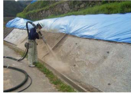
上部シート張り
