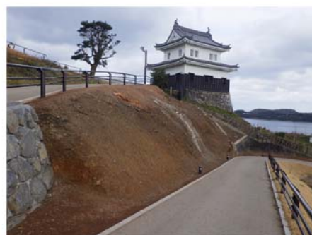
法面清掃完了
