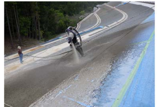
盛土法面吹付
