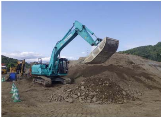
専用除礫バケットによる篩い分け
