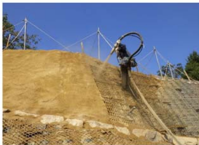
着色吹付状況(バイフェロックス4920)
